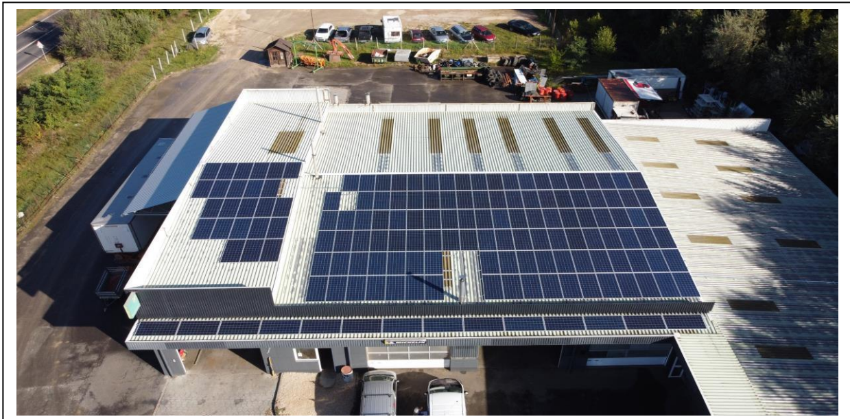
48,640 kW teljesítményű napelemes rendszer
